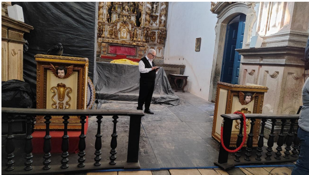
Legenda: Intervenção no piso de campa da Capela-Mor Autoria: Francielle Ferreira Data: 19/06/2024
