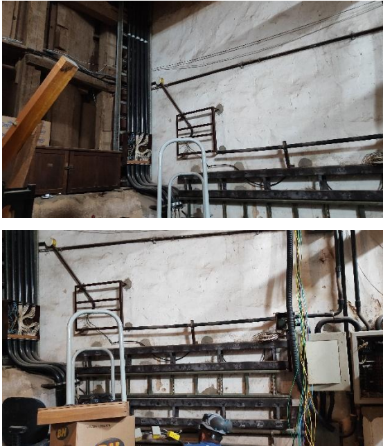
Legenda: Execução de infraestrutura elétrica e montagem de quadros de distribuição. Autoria: Francielle Ferreira Data: 19/06/2024
